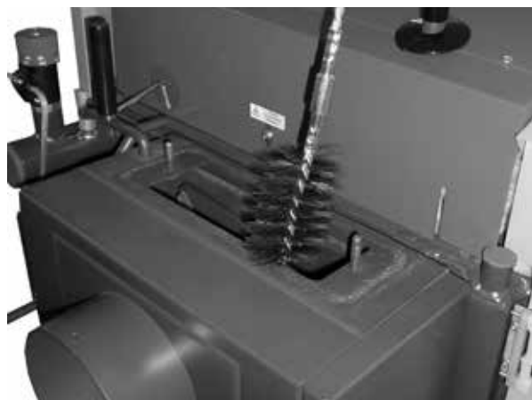
Vorführung der Reinigung des Rauchkanals mit Drahtbürste.
