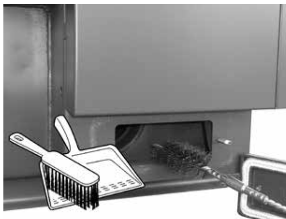
Vorführung der Reinigung des Rauchkanals mit Drahtbürste.
