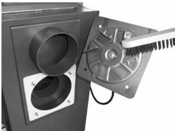
Die Reinigung des Umlafrad und die Kontrolle des Schaufels bei Saugzugventilator
