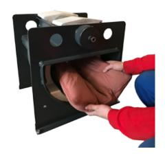
9. Bevor Sie mit der Demontage der einzelnen Rostelemente beginnen legen Sie zum Schutz der Keramik eine Abpolsterung in den Brennraum.
